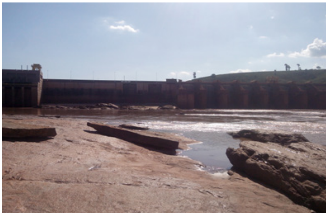
Foto 4: A usina hidrelétrica de Mascarenhas
